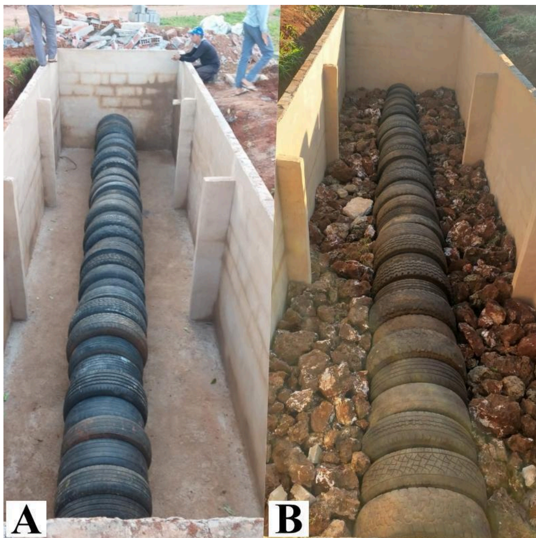
Figura 6. (A) Duto de pneus e (B) preenchido com entulho de obra (tijolos, telhas e pedras) da Fossa de Evapotranspiração (TEvap).
