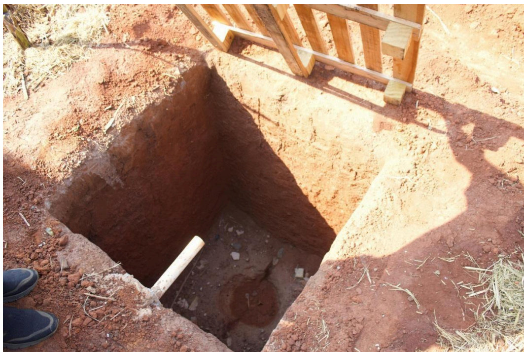
Figura 3. Abertura de uma vala com 1,0 metro de diâmetro e 1,0 metro de profundidade do Círculo de Bananeira.
