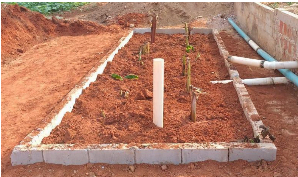
Figura 8. Fossa de Evapotranspiração (TEvap) finalizada.
